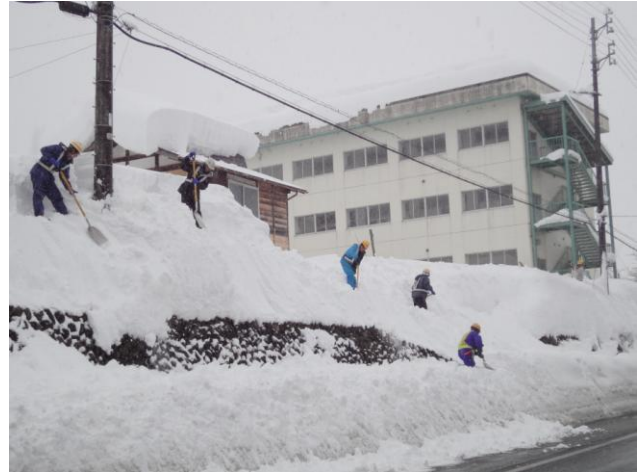
国道沿い歩道の雪庇落とし(1/31)
